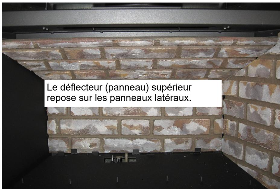
**NOTE:** L'installation des panneaux dans une position autre que celle illustrée entraînera une mauvaise flamme et la formation de suie sur les bûches, les panneaux de briques et la vitre frontale.
