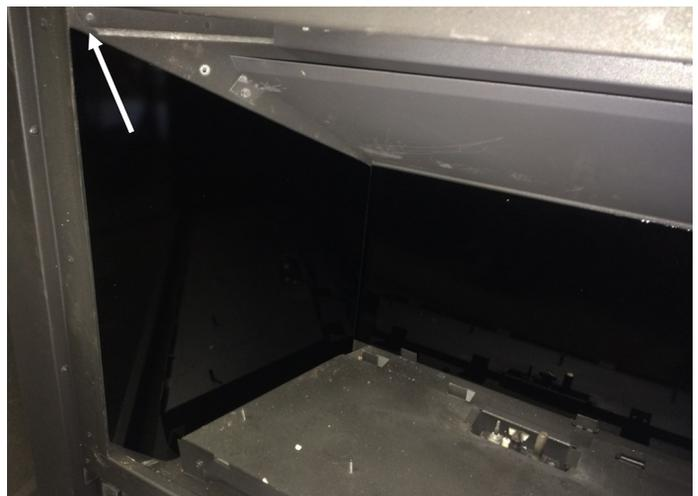
**Étape 03 :** Placez le panneau latéral droit dans la chambre de combustion le long du côté du brûleur. Fixez le panneau latéral avec un clip et une vis (fournis dans le kit).
